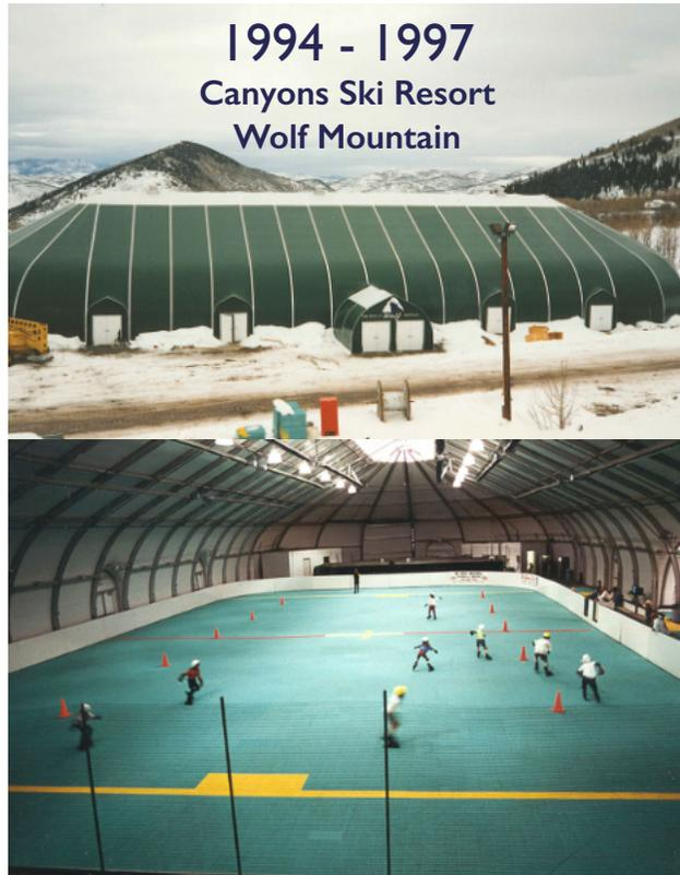
Diese nicht isolierte Struktur wurde 1994 errichtet und für Rollhockey und Konzerte genutzt. Die Sprung-Struktur war angesichts der hohen Wind- und Schneelasten in Utah eine ideale Lösung. Während der Bauarbeiten für die Olympischen Winterspiele 2002 in Salt Lake City, wurde das Gebäude an einen neuen Ort versetzt, um das Gelände für das neue Olympische Dorf zu nutzen.
