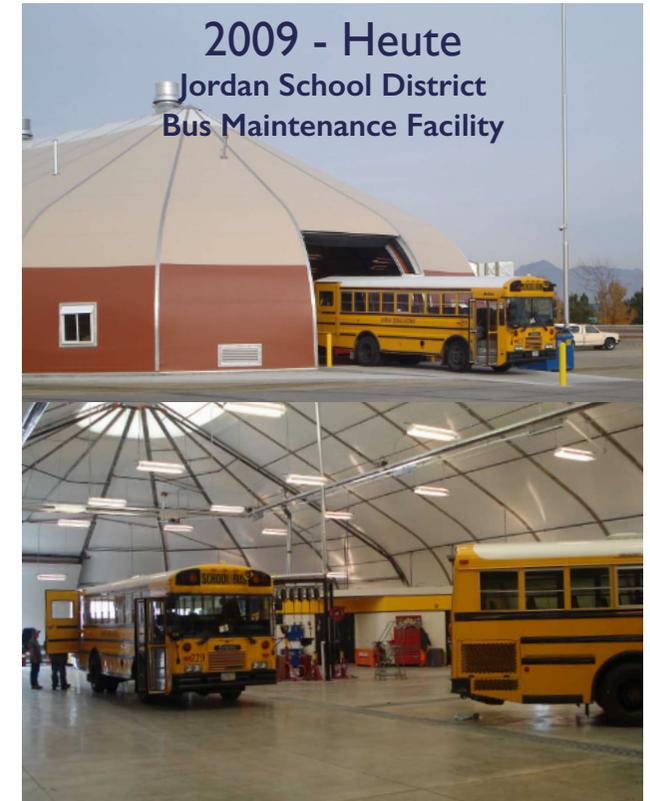
Im 2009 wurde die Struktur vom Jordan School District gekauft und mit einer neuen DuPont Tedlar Aussenmembrane, in den Farben Brownstone Red und Sandstone ausgerüstet. Ebenfalls wurde wo nötig die Isolation teilerersetzt. Das Gebäude wurde wieder an einem neuen Ort als Buswartungsanlage neu aufgebaut.
